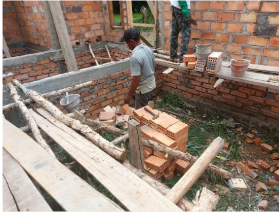
Gambar 3. Pelaksanaan Pekerjaan Pasangan Dinding Bata Sebelum Dilakukan Sosialisasi
