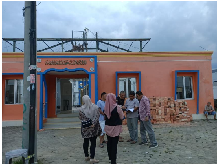
Gambar 7. Pendampingan Implementasi Desain Utilitas Masjid Miftahul Jannah Griya Sako Permai
